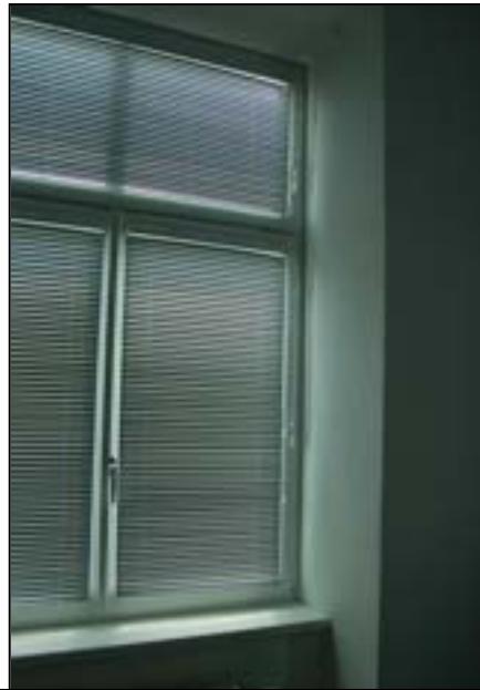
NEU mit Innenjalousien, neuen Innenfensterbänke und Verputzarbeiten
