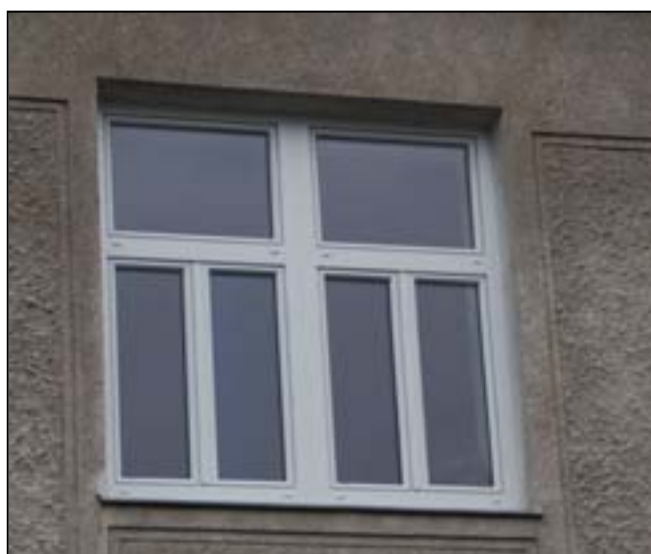
NEU weiße Kunststofffenster mit neuen Außenfensterbänken
