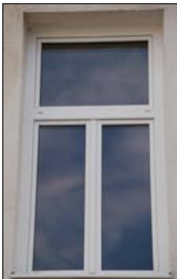
NEU nach innen versetzte Kunststoffenster mit neuen Außenfensterbänken
