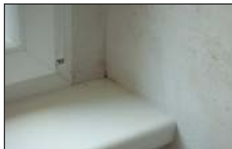
NEU neue Innenfensterbänke mit sauber verputzten Leibungen.
