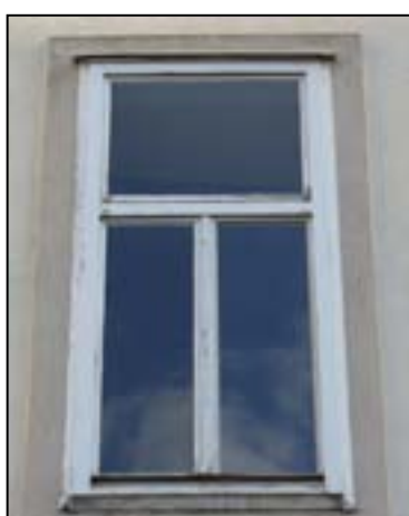
BESTAND außen bündig sitzende Kastenstockfenster
