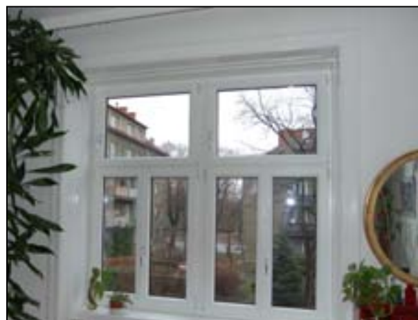
NEU neue Innenfensterbänke mit sauberem Anschluss an die bestehende Leibungsverkleidung
